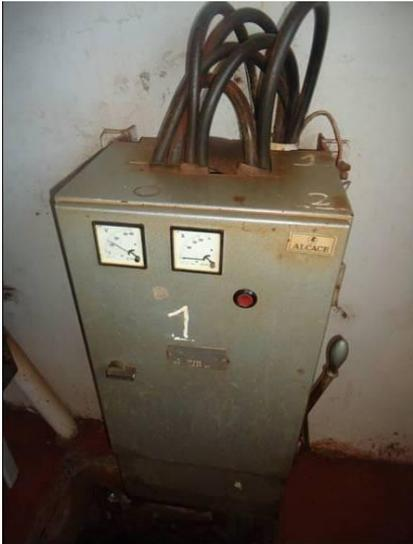
Foto 09 - Detalhe do painel de comando dos conjuntos moto-bombas
