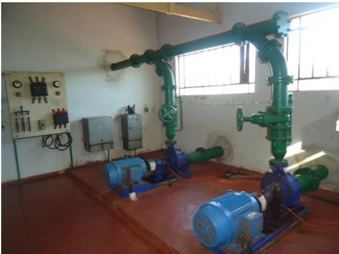
**Foto 06 - Vista dos conjuntos moto bombas e painel de acionamento da elevatória de água bruta**
