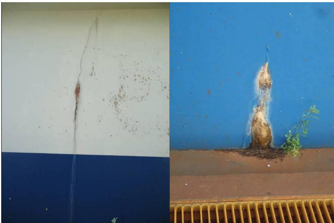
Foto 19 – Trincas e infiltrações aparentes na ETA.
