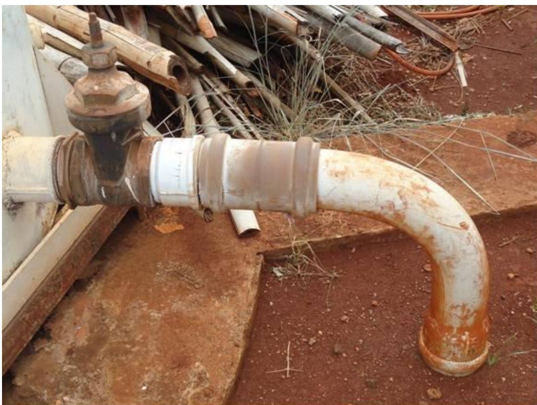
Foto 54 – Detalhe da tubulação de saída de quatro polegadas em PVC.
