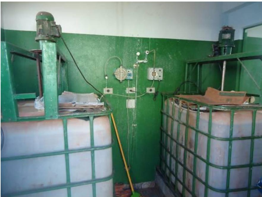
Foto 25 – Detalhe das dosadoras de cal e sulfatos.
