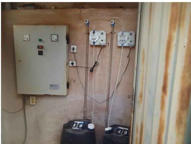
Foto 39 – Detalhe do painel de entrada e dosadoras.
