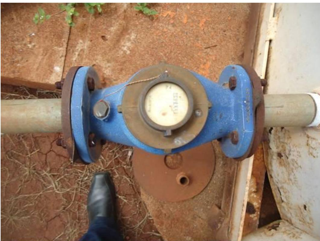
Foto 52 – Detalhe do hidrômetro instalado na entrada, inoperante.
