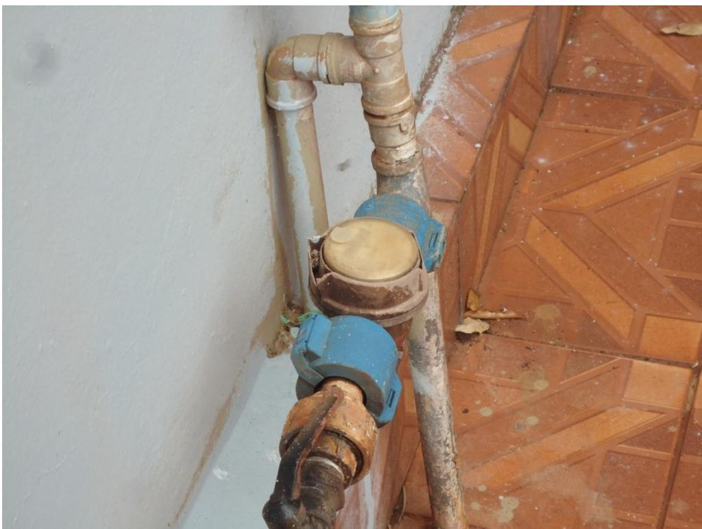
Foto 22 – Exemplo de hidrômetro antigo, sem abrigo e embaçado
