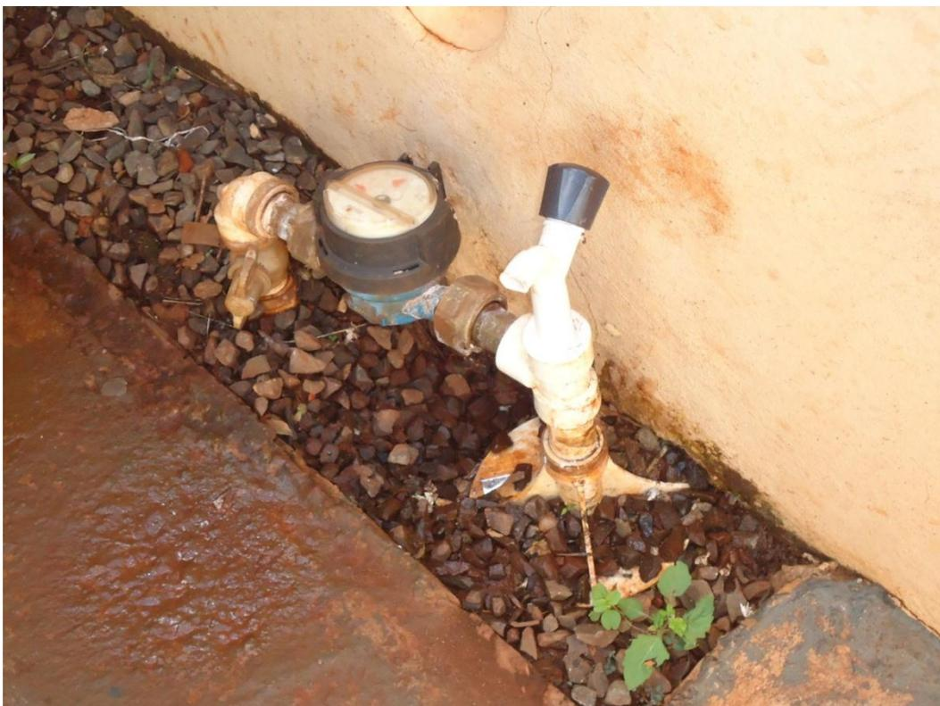
Foto 21 – Exemplo de hidrômetro com vazamento no pé do cavalete e sem lacre
