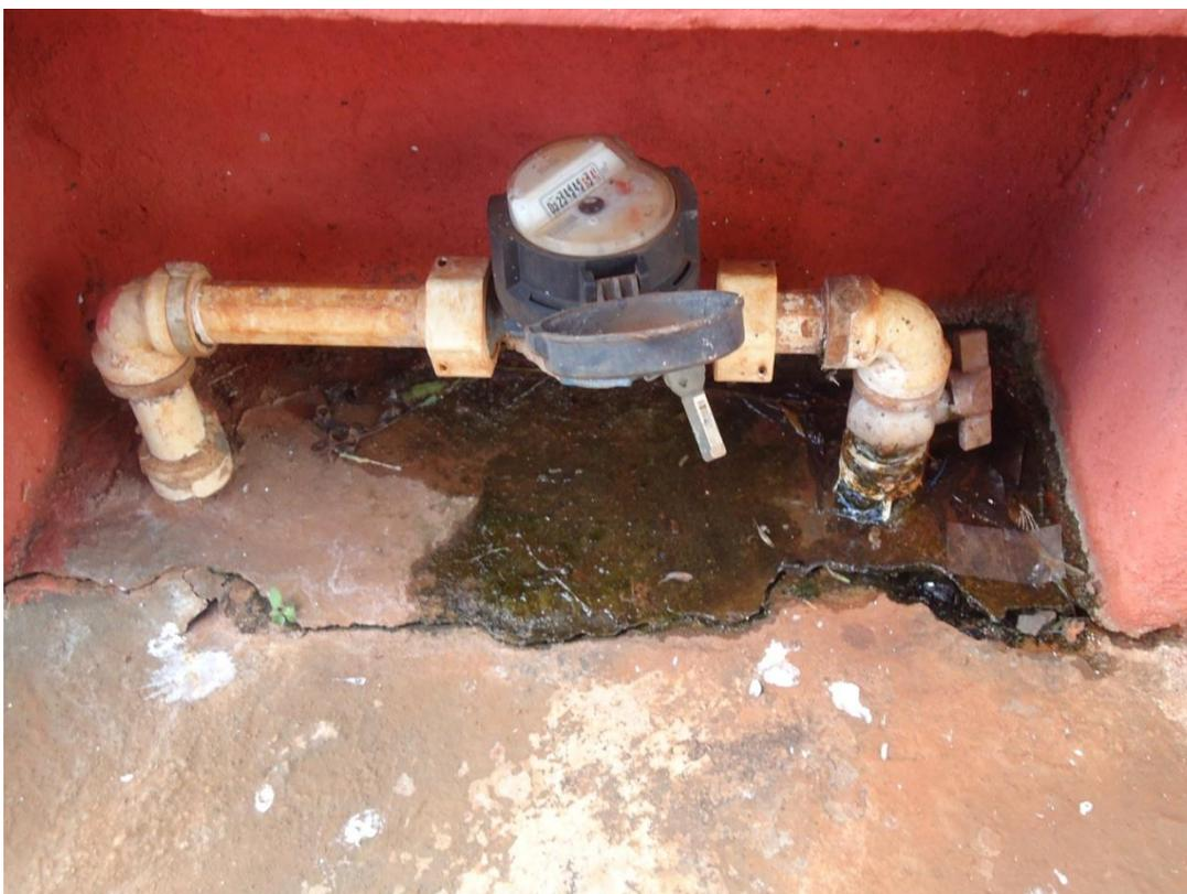
Foto 19 – Exemplo de hidrômetro com vazamento no pé do cavalete
