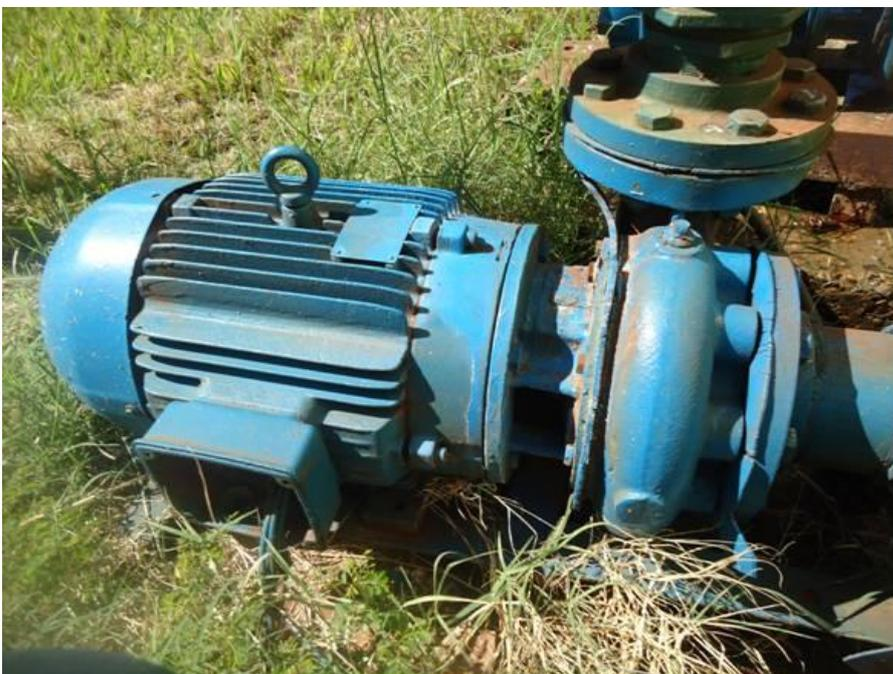
Foto 31 – Detalhe de um dos conjunto moto-bombas da ETA.
