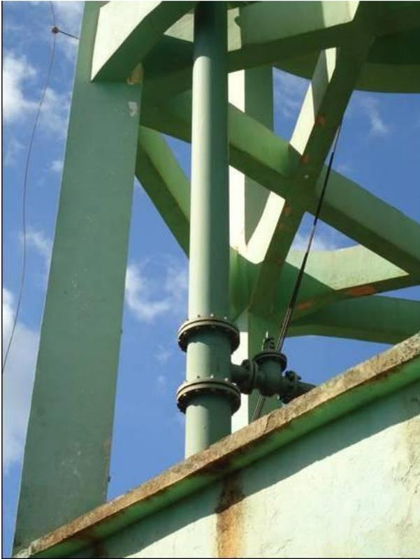
Foto 32 – Detalhe da tubulação de saída do R1,
