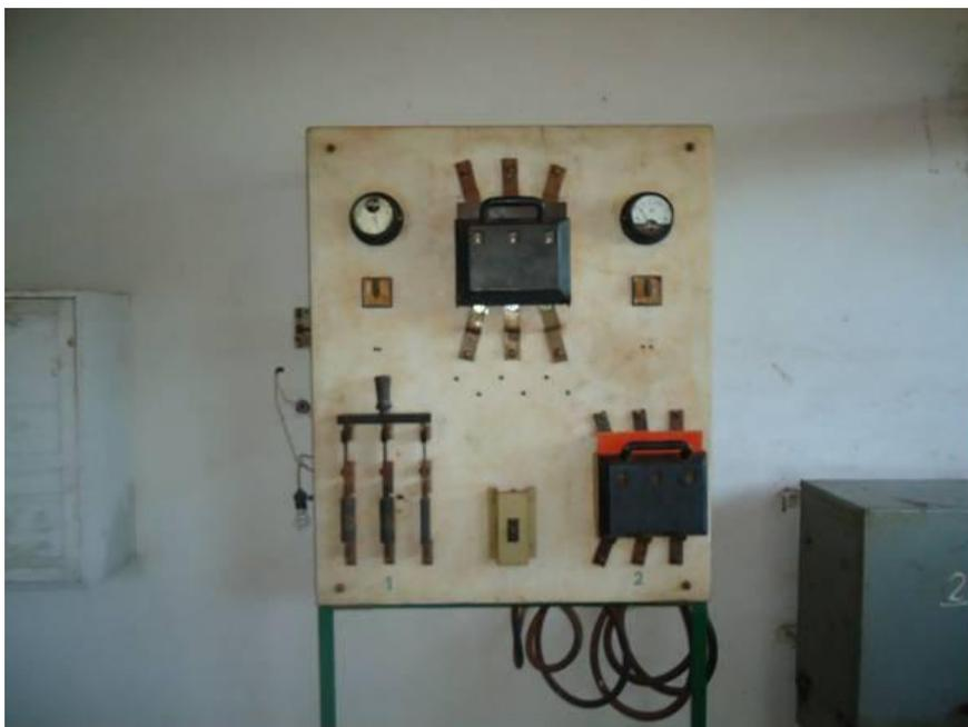
Foto 08 - Detalhe do painel de comando dos conjuntos moto-bombas
