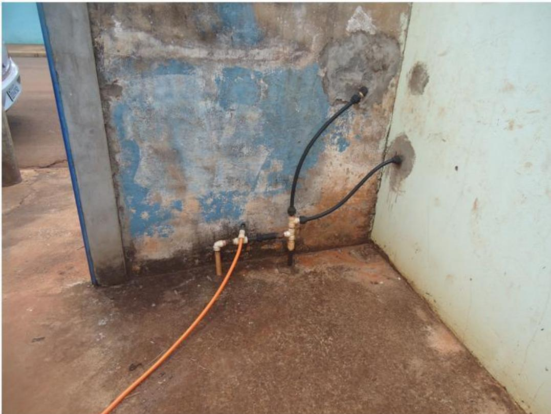
**Foto 09 – Detalhe da ligação na “Bica – R3”, com cavalete sem hidrômetro e derivação ao abastecimento da EMEF Altair Pontremoles**
