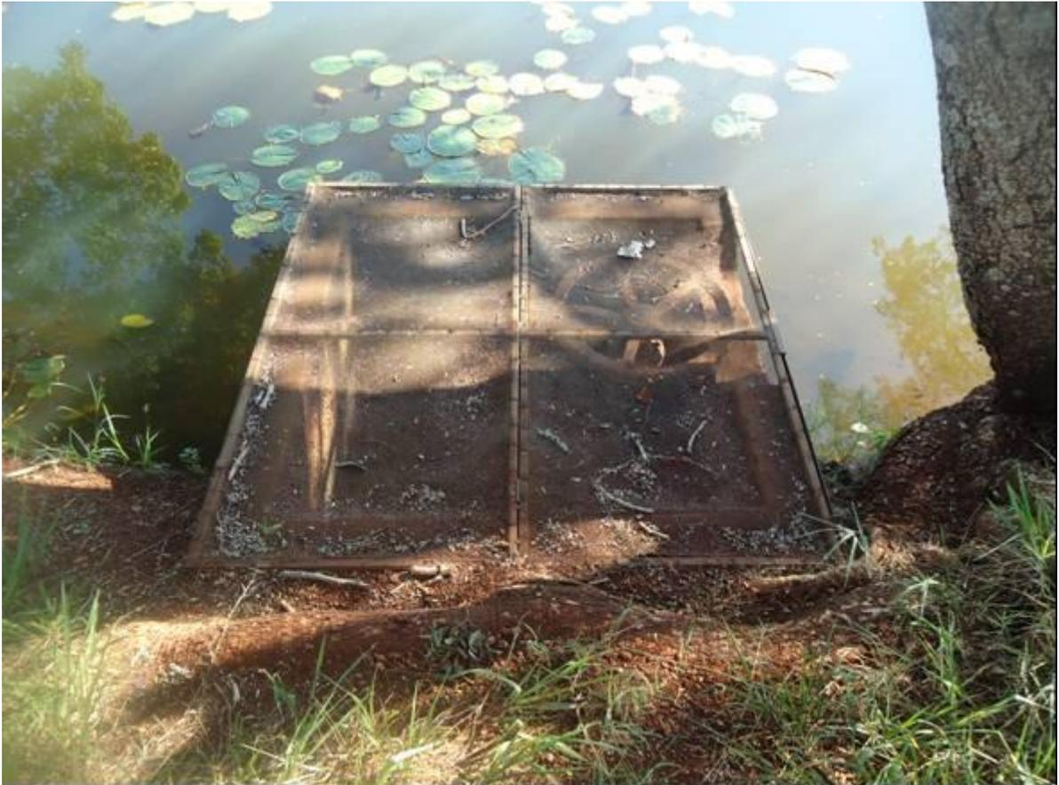
Foto 02 – Detalhe da captação no açude Barra Bonita
