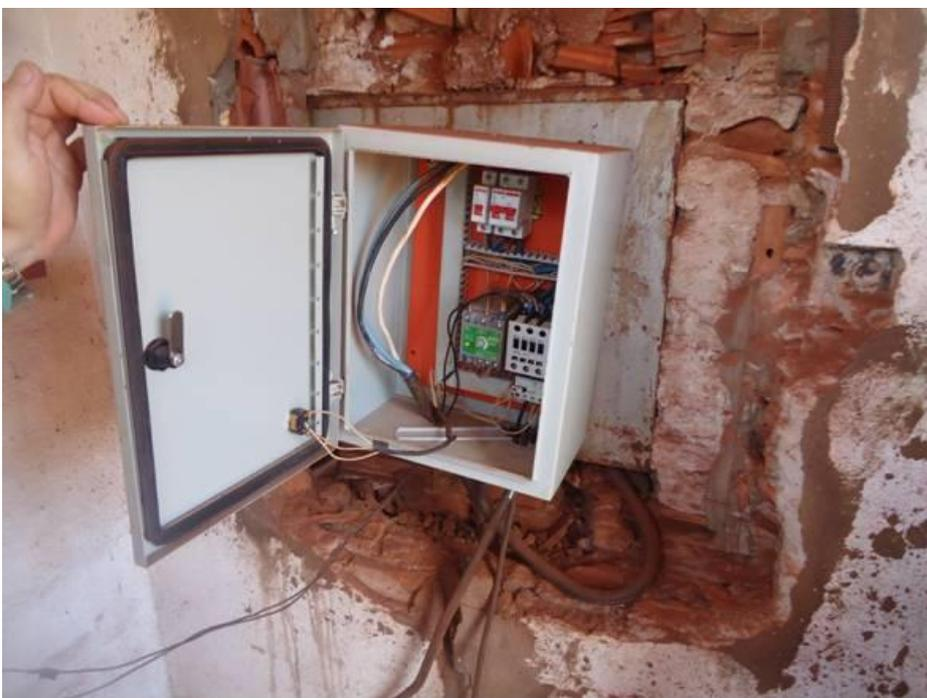
Foto 36 – Painel de entrada no poço Ribeirão Vermelho.
