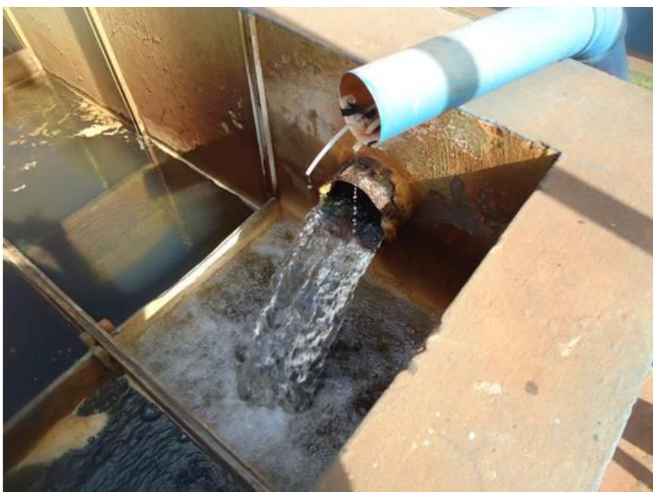
Foto 14 – Detalhe da tubulação de chegada na ETA.
