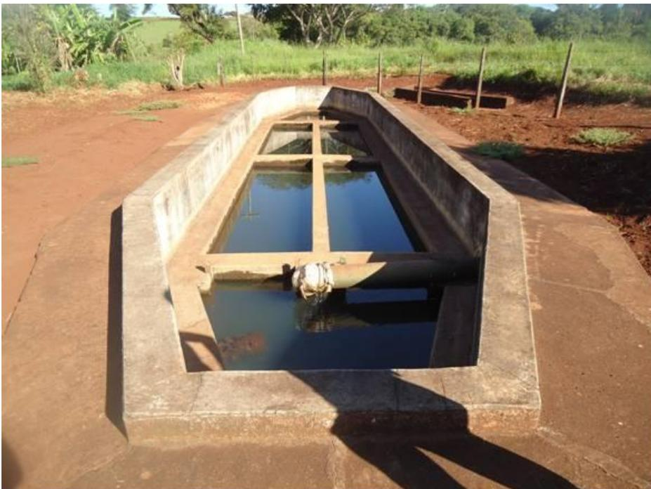
Foto 03 – Poço de entrada de água bruta
