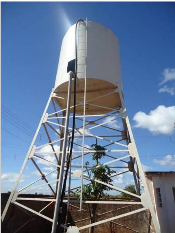
Foto 35 – Reservatório elevado, fora de operação no poço Ribeirão Vermelho..
