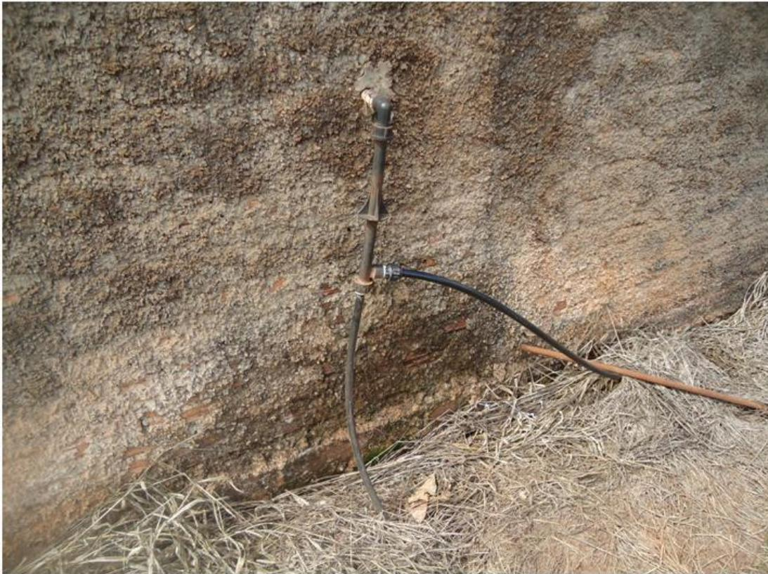
Foto 11 – Detalhe da ligação da “Bica - Ginásio”, sem cavalete em uma ligação direta
