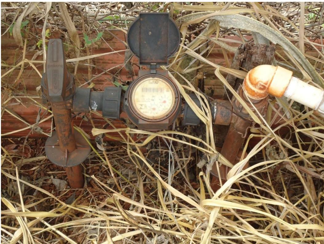
Foto 22 – Exemplo de hidrômetro antigo e inclinado
