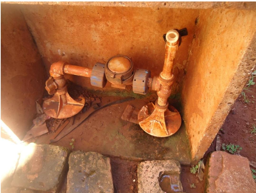
Foto 18 – Exemplo de hidrômetro antigo e com cúpula embaçada
