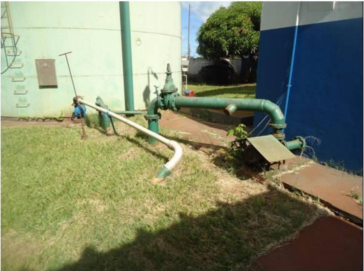
Foto 27 – Detalhe das tubulações de entrada e recalque aos reservatórios.
