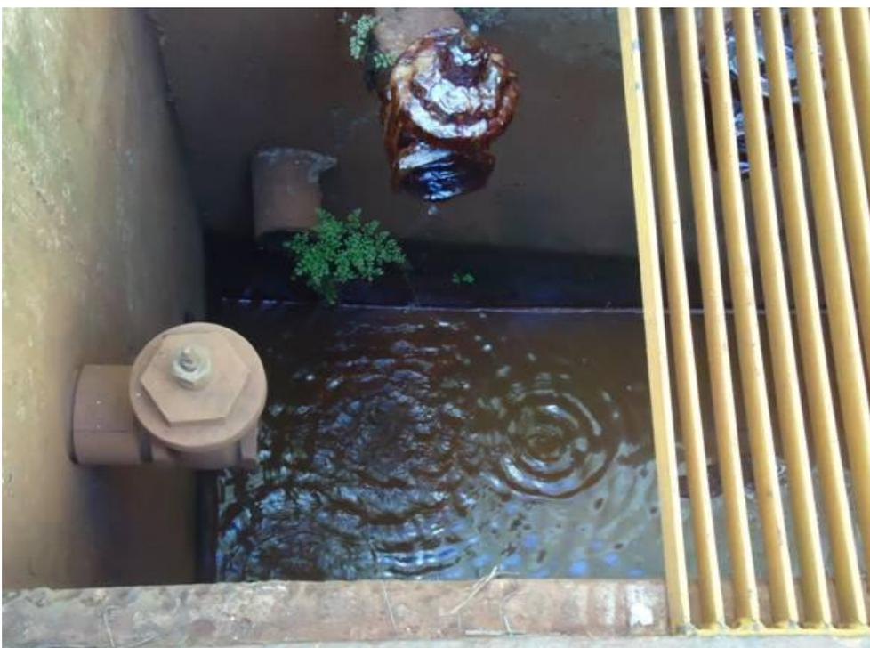
Foto 20 – Vazamentos nas válvulas de descarga da ETA.
