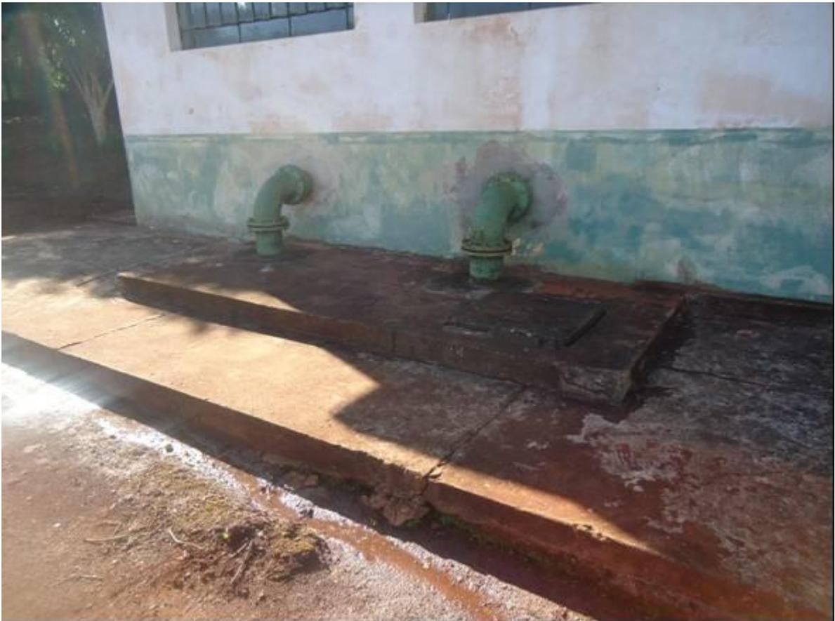
Foto 05 – Detalhe do poço de sucção de água bruta
