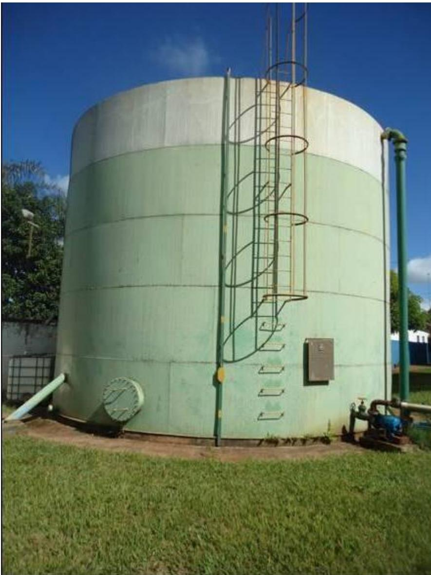
Foto 29 – Reservatório R2, apoiado, com capacidade de 300 m<sup>3</sup>.
